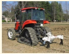
【例】排水対策（暗渠）
