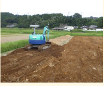
土層改良（客土）
