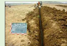
暗渠排水工事の竣工
