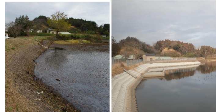
高上げ工事前後のため池堤体
