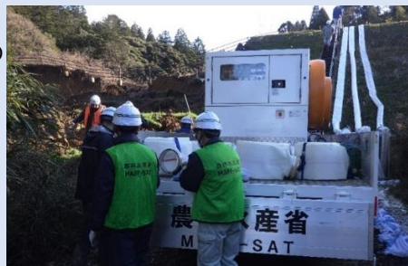
MAFF - SATによる災害応急対策の支援 (ため池における排水ポンプの設置)
