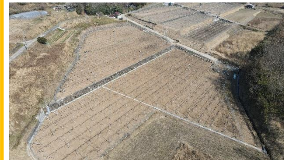
新たに造成した梨団地(入江地区)
