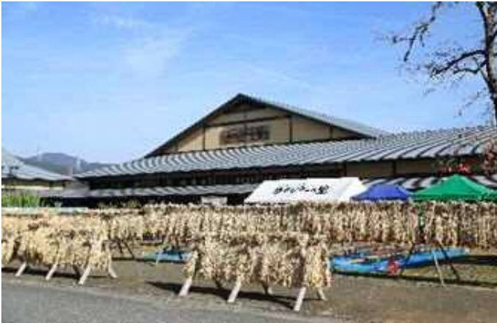
みなみの里全景
