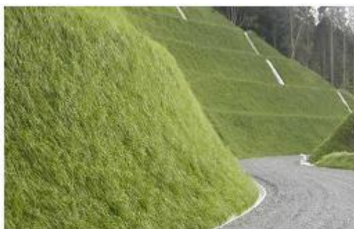
【付け替え道路法面の緑化】
