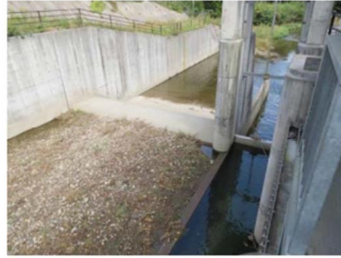
写真 5-3-2 頭首工全景(上流側)
