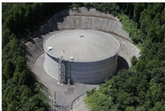
写真 5-7-5 帯野ファームポンド
