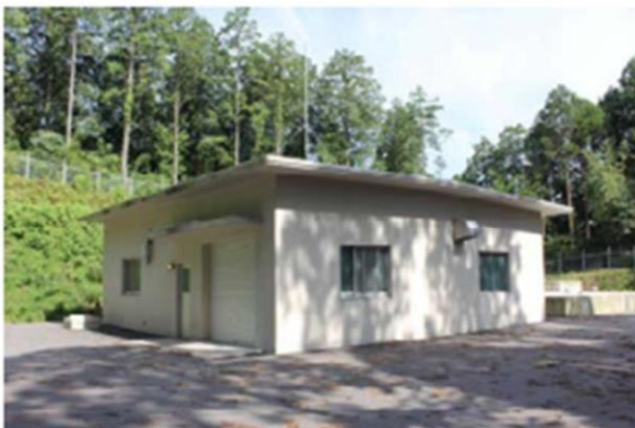
写真 5-6-5 高之峯揚水機場(外観)
