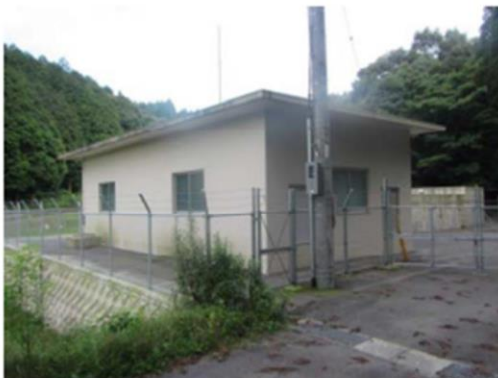
写真 5-6-3 大峯揚水機場(外観)
