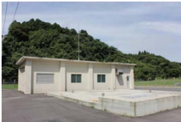
写真 5-6-7 外園揚水機場(外観)
