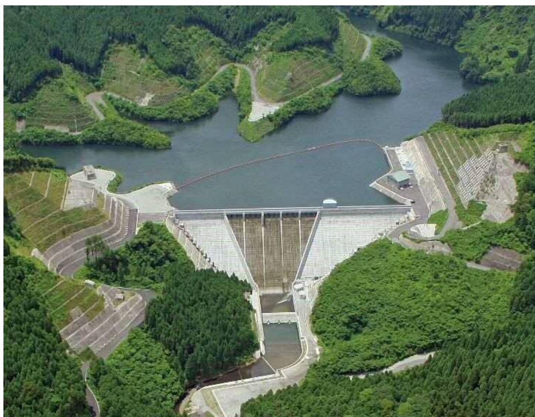
曾於市：谷川内ダム
