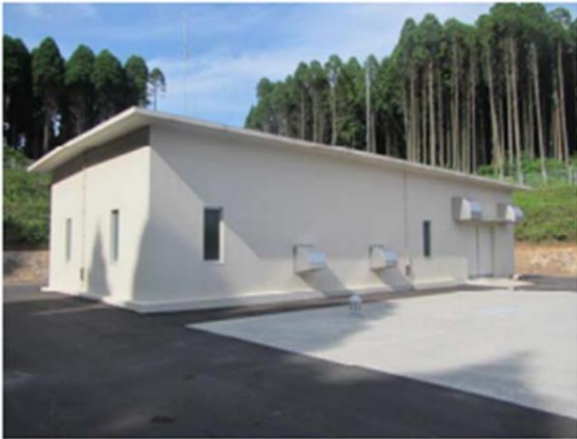
写真 5-6-1 金丸揚水機場(外観)
