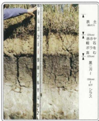
シラス台地の法面状況
