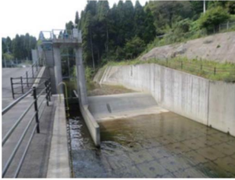
写真 5-3-1 頭首工全景(下流側)
