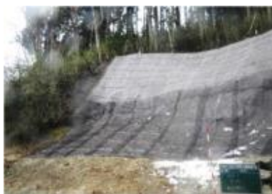
H27 年施工の法面保護工
