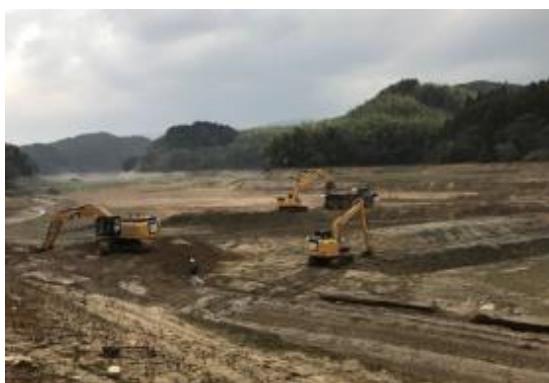
北山ダム堆砂除去状況
