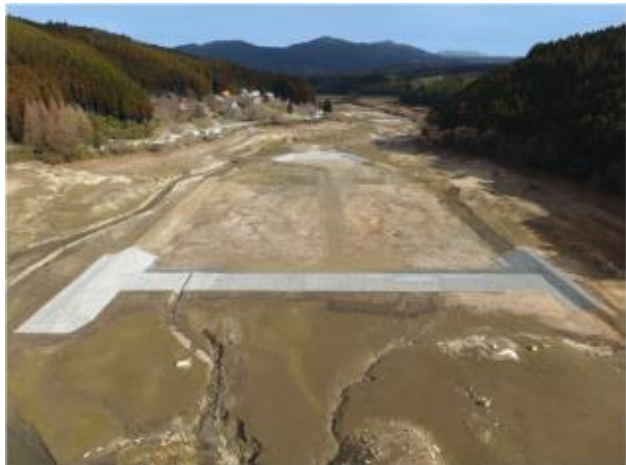
初瀬川貯砂施設
