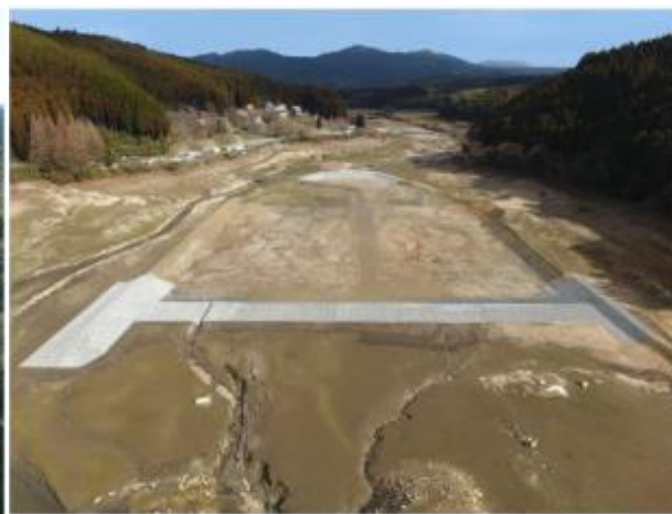
貯砂施設工（初瀬川貯砂施設）
