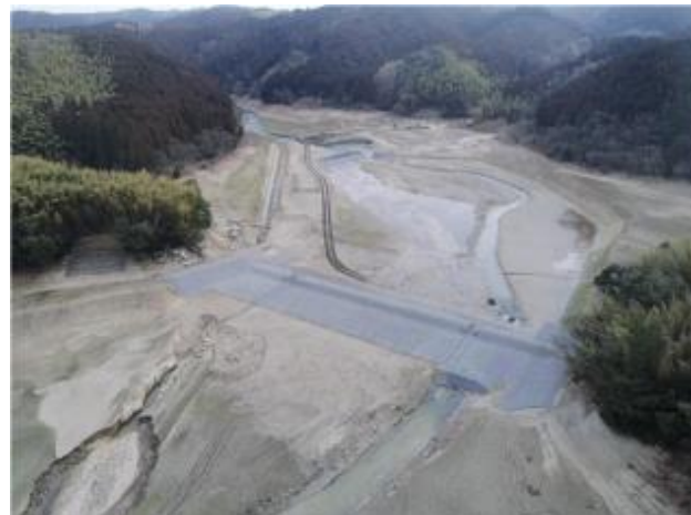
嘉瀬川貯砂施設
