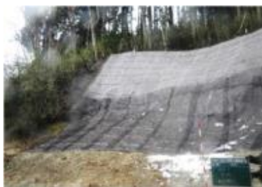
H27 年施工の法面保護工
