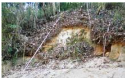
工事前の状況 (H27)
