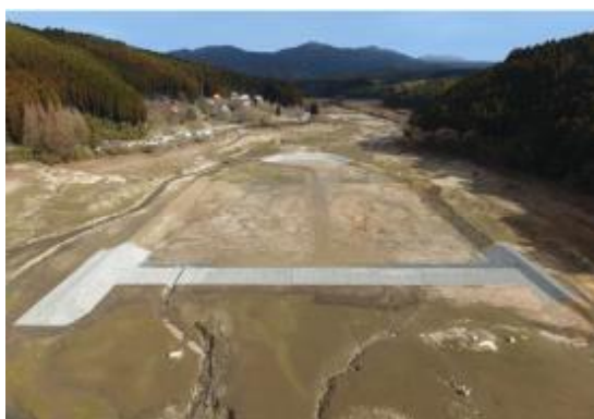
初瀬川貯砂施設(下流より望む)
