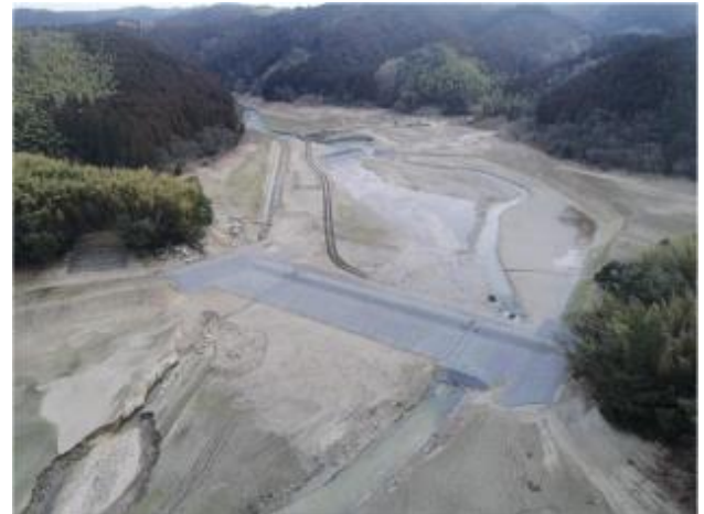
嘉瀬川貯砂施設
