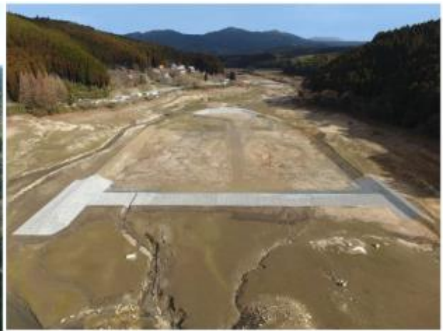
貯砂施設工（初瀬川貯砂施設）
