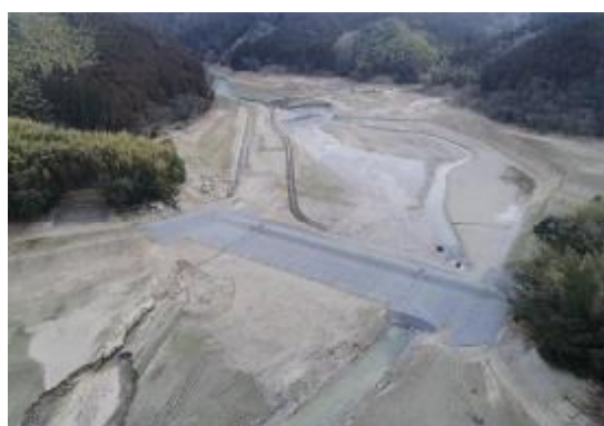
嘉瀬川貯砂施設(下流より望む)
