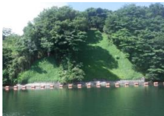
植生マット(上部)、浸食防止マット(下部)(植生後)
