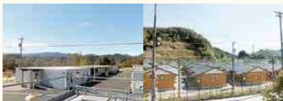
整備された仮設住宅（左：ムービングハウス 右：木造）
