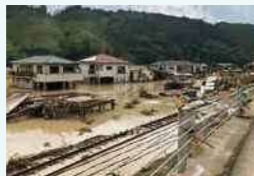
被災状況（住宅浸水）
