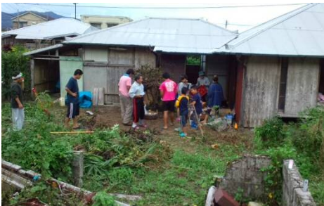
地域ぐるみで空き家を改修
