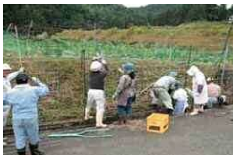
写真4. ワイヤーメッシュ防護柵の設置
