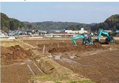
復旧工事の様子
