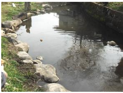
農業用水路への通水状況
