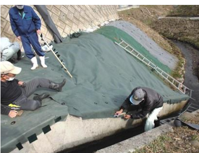
防草シートの敷設
