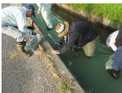
防草シートの敷設
