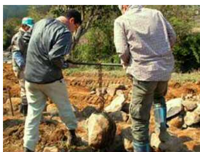
石垣積み教室
