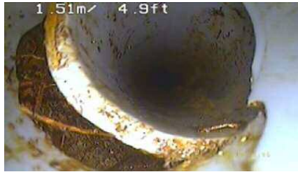
図-4 孔内カメラ調査結果 (塩ビ管の破断)
