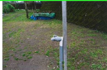
農園内に設置されている水道
