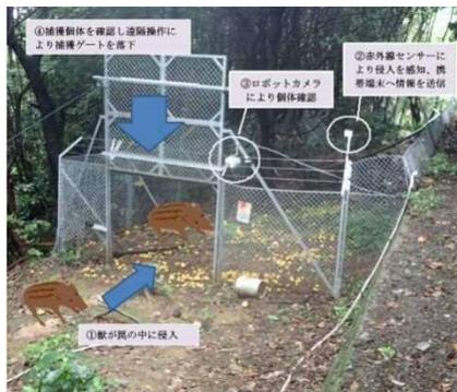
カメラによる遠隔操作を利用したICT大型誘導捕獲罠
