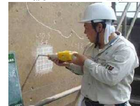
老朽化した施設の機能診断
