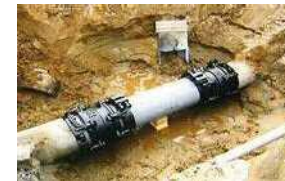
漏水防止のための整備
