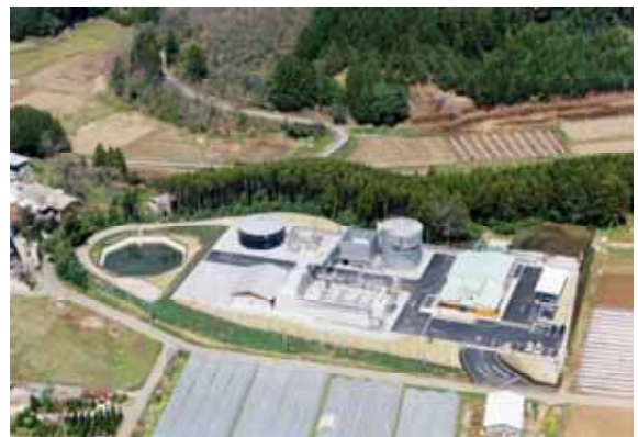
日田市バイオマス資源化センター
