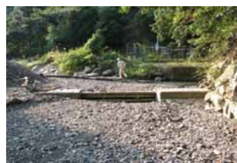
片井野川の湯水状況
