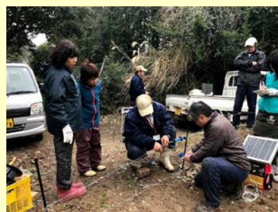
防護柵 (電気柵設置中)
