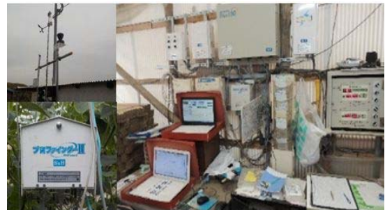
「P Cがセンサーの信号を受け制御装置を操作」
