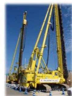
止水壁の施工状況
