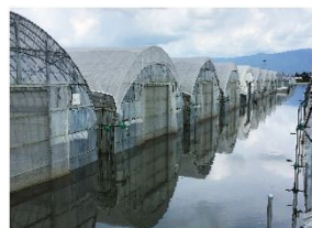
令和2年7月豪雨冠水被害 （福岡県小郡市）
