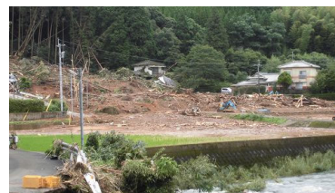
山腹崩壊土砂流入 (熊本県芦北町)
