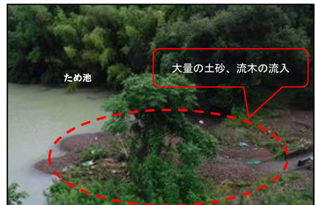
令和2年7月の大雨により被災した農業用ため池
