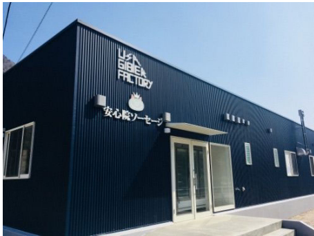
完成したジビエ処理施設
