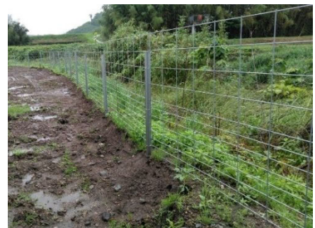
養豚農場に設置された野生動物侵入防止柵（宮崎県）
