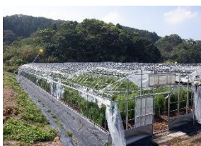
令和2年9月台風第10号被害 （長崎県松浦市）
