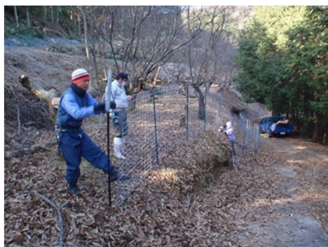
鳥獣侵入防止柵の設置作業
