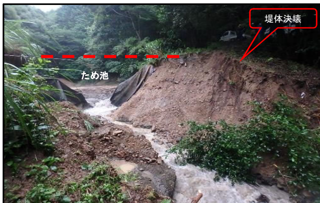
令和2年7月の大雨により被災した農業用ため池
