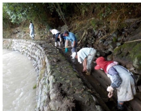
用水路復旧状況（土砂上げ） 熊本県錦町農地・水・環境保全管理協定運営委員会
