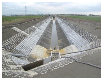
法面保護直後のクリーク
