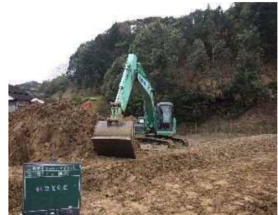
基盤整備の様子
