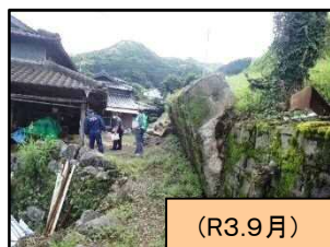
災害査定実施状況 (長崎県波佐見町)
