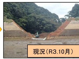
被災したため池の応急対策実施状況:(右写真)堤体開削後 (佐賀県唐津市)
