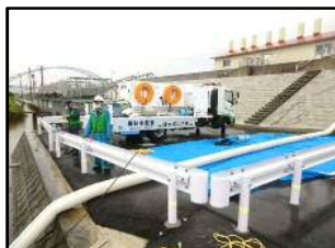
排水ポンプ車による排水状況 (福岡県大牟田市)
