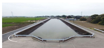
防災事業により、安定した水利用が可能となったクリーク (筑後川下流右岸地区(佐賀県))
