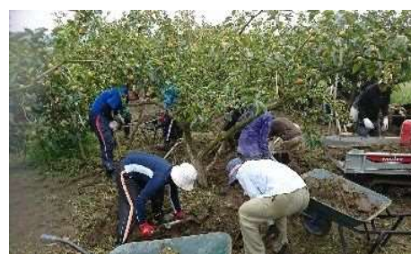
災害復旧の様子
