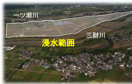
ドローンによる被災地の空撮 （宮崎県西都市）
