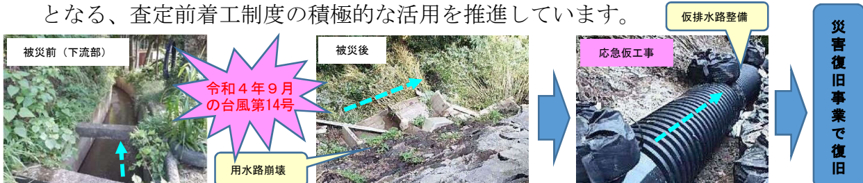
令和4年9月の台風14号の影響により被災した農業用用水路の応急仮工事事例
