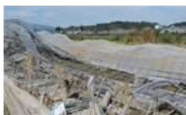
台風による農業用ハウスの倒壊 (宮崎県新富町)
