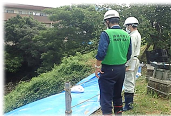
農林水産省の職員派遣による支援（MAFF-SAT） 被害状況調査
