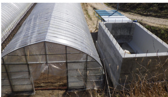
復旧途中のハウスと灌水施設
