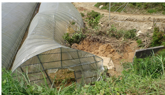
土砂が流入したハウスと灌水施設
