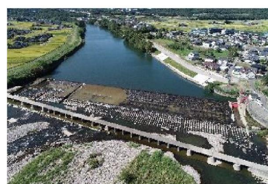
⑥平田頭首工
