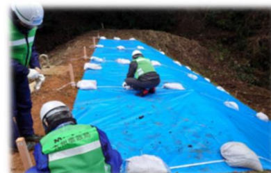
技術系職員による農業用ため池の応急復旧作業
