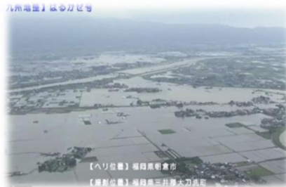
防災ヘリ(九州地方整備局)による被災地の空撮 (福岡県久留米市付近)
