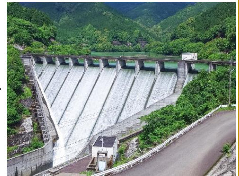
広沢ダム（管理施設の改修）
