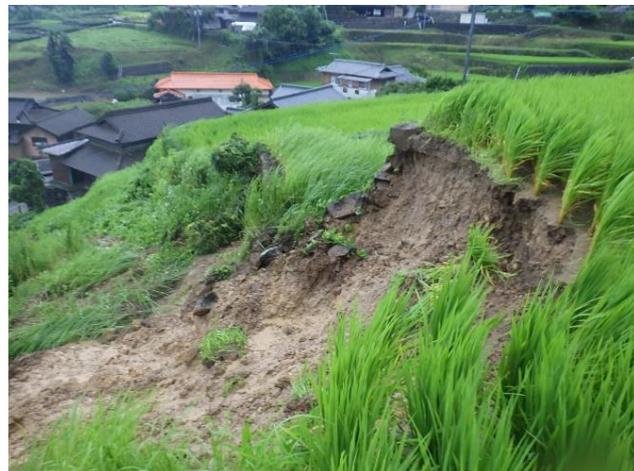
令和3(2021)年8月の豪雨で崩壊した棚田の石垣
