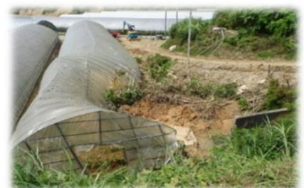
土砂崩れによる 農業用ハウスの破損 (佐賀県佐賀市)
