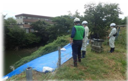
技術系職員による農業用 ため池の被害状況調査
