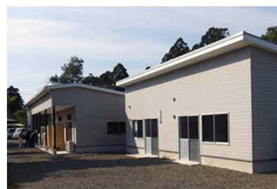
屋久島ジビエ加工センター外観
