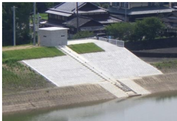
焼米ため池事前放流施設（上流側）
