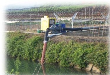
取水用応急ポンプ貸出 (熊本県熊本市)
