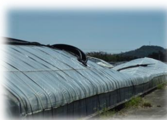
花きビニールハウスの損壊 (鹿児島県枕崎市)
