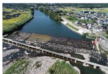
⑥平田頭首工
