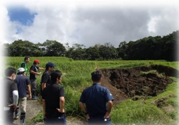
技術系職員による被災状況調査 (鹿児島県錦江町)
