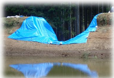
被災ため池の応急対策を支援 (大分県国東市)
