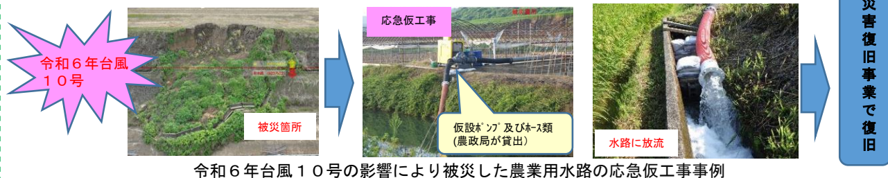
令和6年台風10号の影響により被災した農業用水路の応急仮工事事例
