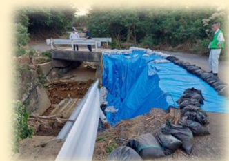
技術系職員による被災 状況調査
