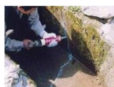
【ひび割れの補修】
