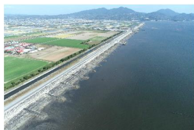
海岸事業で高潮・波浪及び大規模地震対策を行った海岸堤防 (玉名横島地区(熊本県))
