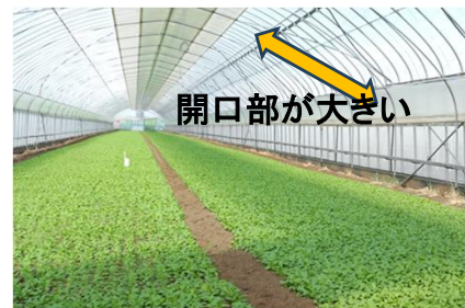
大型換気窓付きハウス
