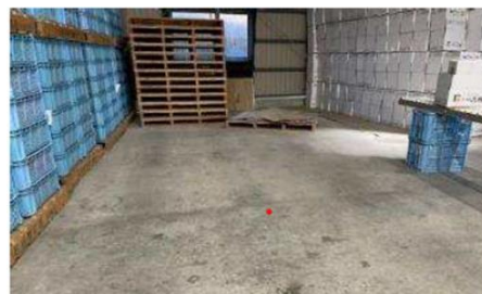
整理整頓された庫内
