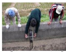
【施設の機能診断】
