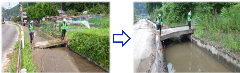
技術系職員による被災状況調査 (鹿児島県霧島市)
