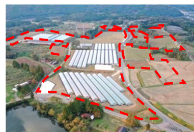
区画整理により集積されたベビリーーフ団地 (駅館川地区(大分県))
