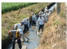
【水路の泥上げ】
