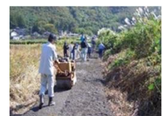
【未舗装農道の舗装】
