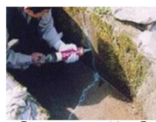
【ひび割れの補修】
