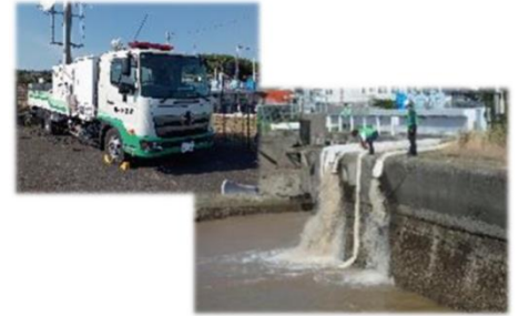
排水ポンプ車による排水状況 (熊本県上天草市)
