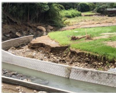
水田への土砂流入 (鹿児島県始良市)
