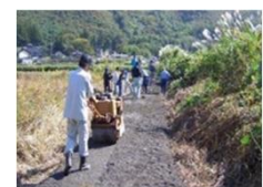
【未舗装農道の舗装】
