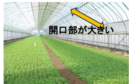
大型換気窓付きハウス
