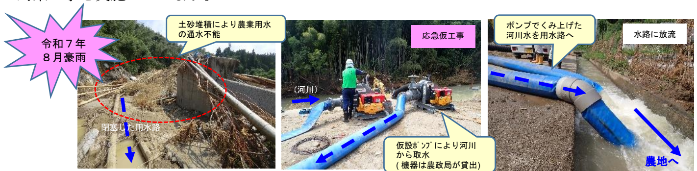
令和7(2025)年8月豪雨により被災した農業用水路の応急仮工事の事例
