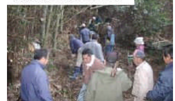
散策道設置工事
