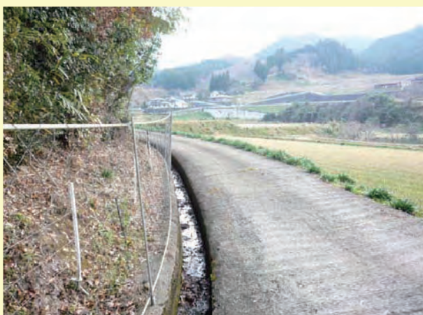
集落全体を取り囲む電柵と防護柵
