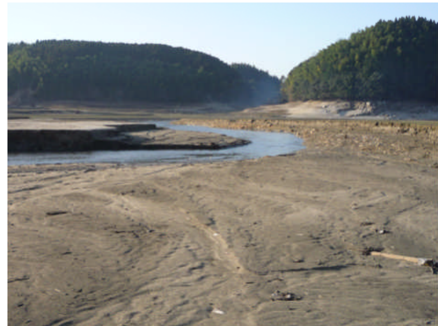
貯水池内の堆砂状況
